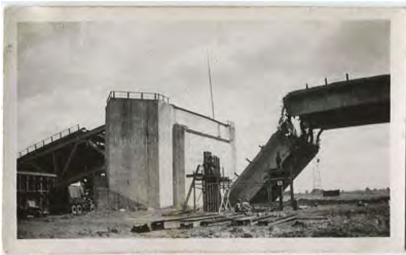
Abbildung 3 Hohenwarthe gesprengte Elbbrücke 1945 Quelle: US Army
