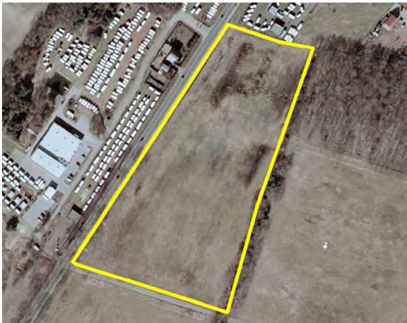
Luftbild gewerbliche Bauflächen Erweiterung Gewerbegebiet Brunnenbreite Möser / Körbelitz
